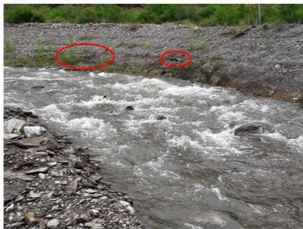
Illustration 3 – Vue de la protection en pied de la verse de Nartau et identification de laisses de crue
